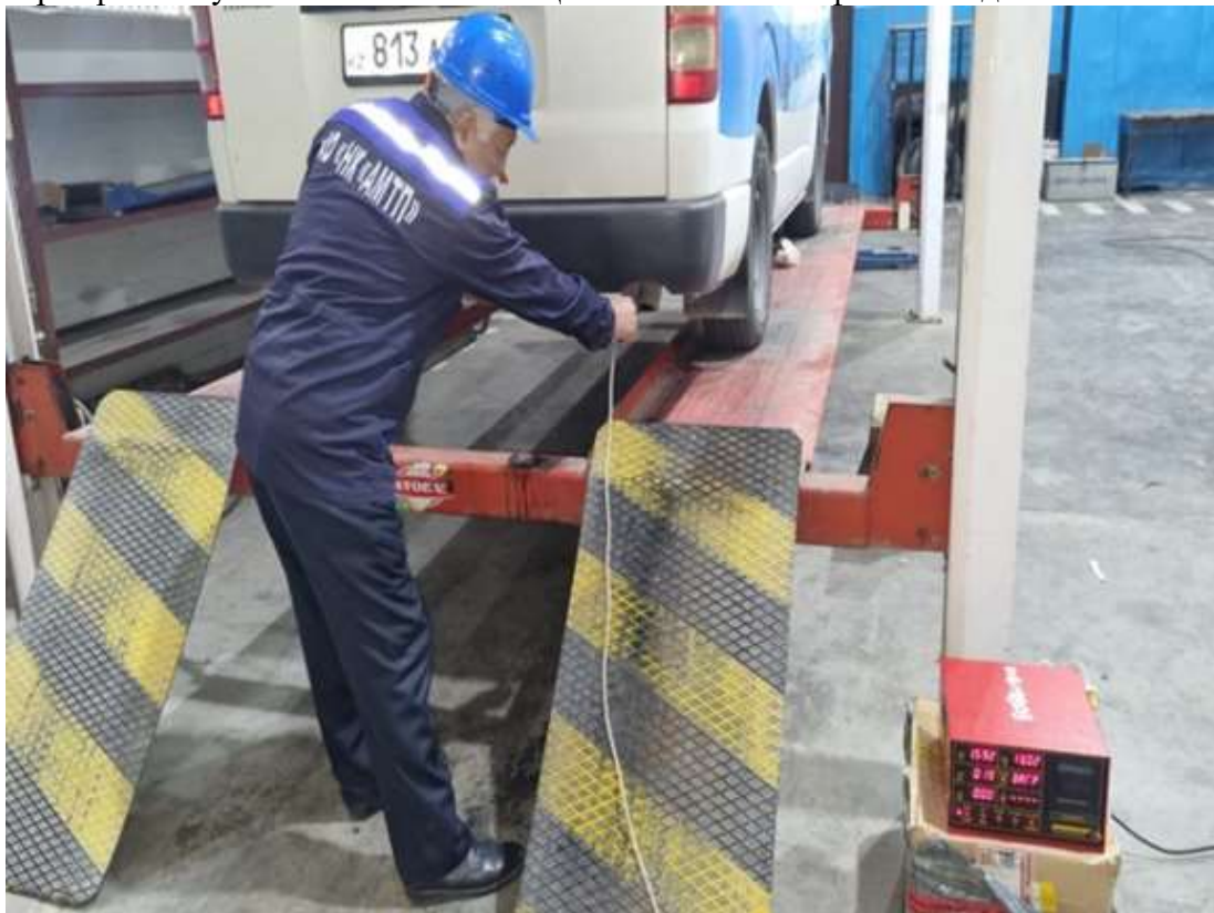
Газ талдағыштағы шпен пайдаланылған газдарда СО және СН өлшеу үдерісі
